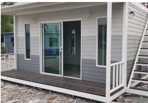
บ้านประกอบเสร็จ
