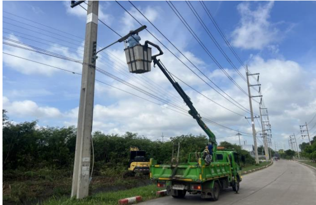
งานปรับปรุงถนน
