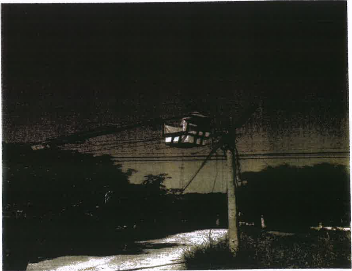
ภาพถ่ายขณะดำเนินการซ่อมแซมไฟฟ้าสาธารณะ บริเวณ ซอย ๒ หน้าบ้านนางแปร ช่างจัตุรัส
